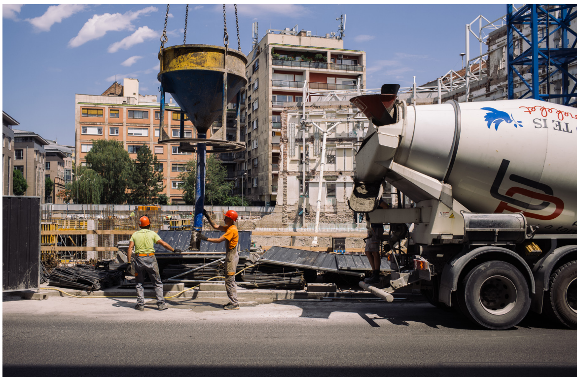
Le chantier rue Bem Jozsef U, où Azedine travaillait lorsqu'il vivait à Budapest.
